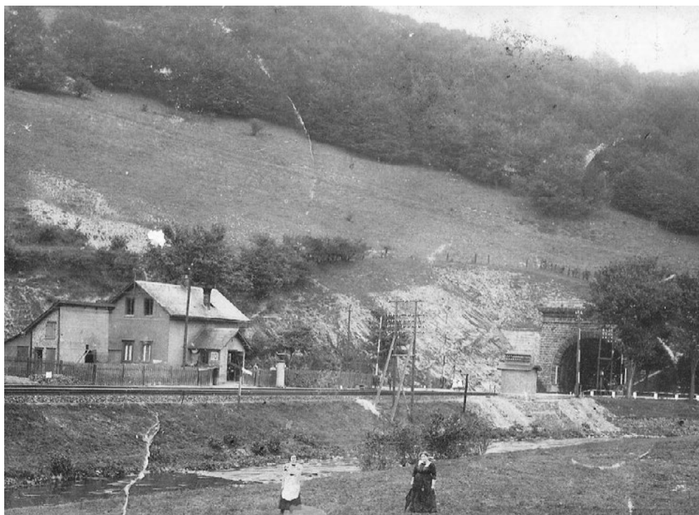
Dom (stacja kolejowa) rodziny Kawulów w Hoppecke (w tle na wzgórzu las). Widoczny nasyp i tunel kolejowy oraz umieszczona na ścianie tabliczka z literami „HO” – stacja Hoppecke. (fot. ze zbiorów Henryka Kawuli z Wodźnicznej)
