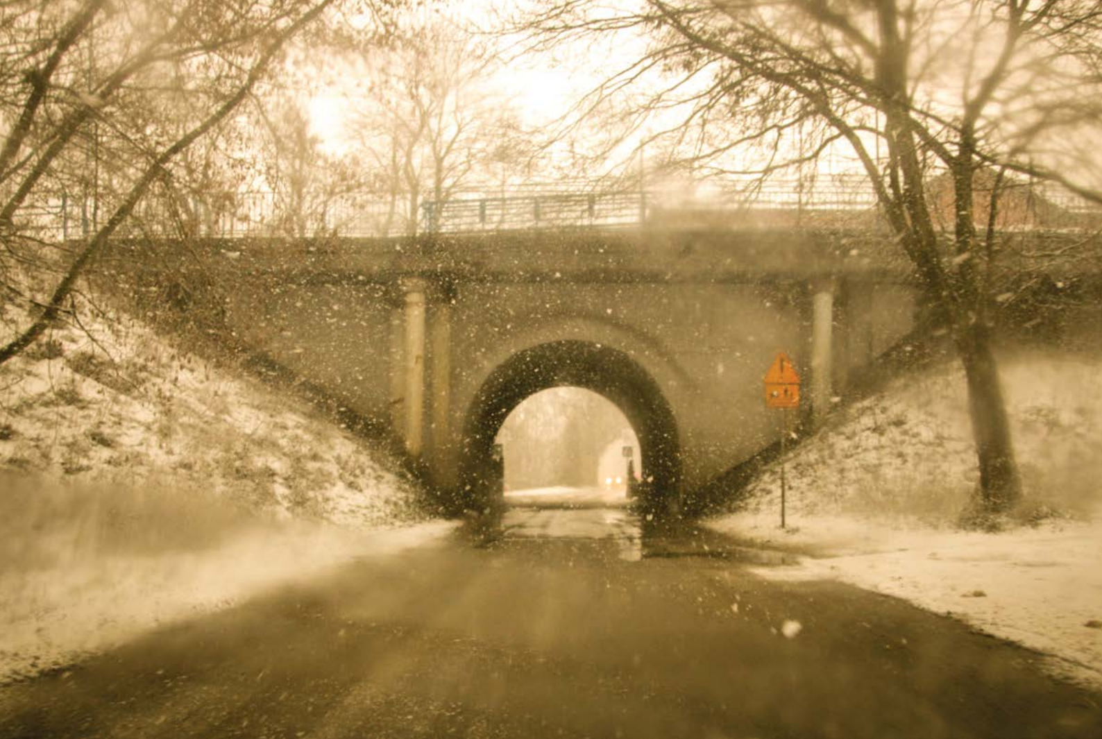
BRAMA PIERWSZA Dworzec PKP w Kępie, ul. Dworcowa, I 2017
