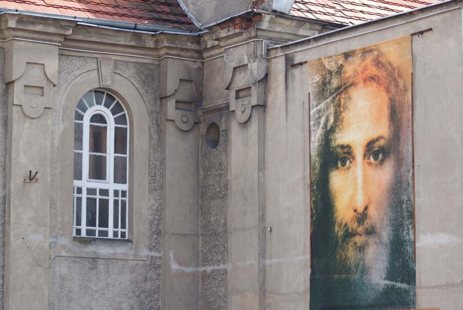
KATOLICKI DOM Dom Katolicki w Kępnie przed remontem, IV 2012
