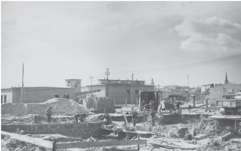
Fundamenty pod biurowiec.
