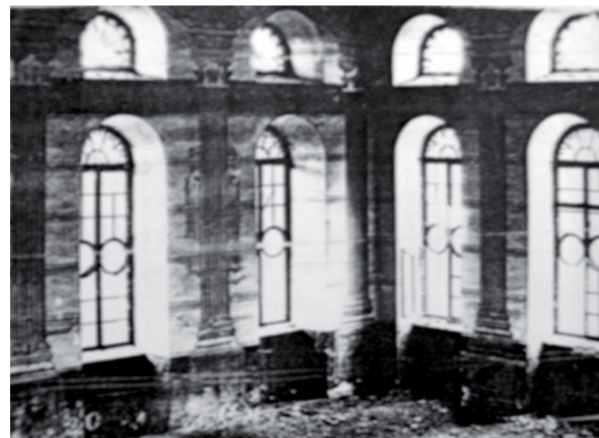
il. 9. Widok na naroże ściany wschodniej i południowej. Stan przed 1956 r. Źródło: Archiwum Wielkopolskiego Konserwatora Zabytków, Delegatura w Kaliszu.
